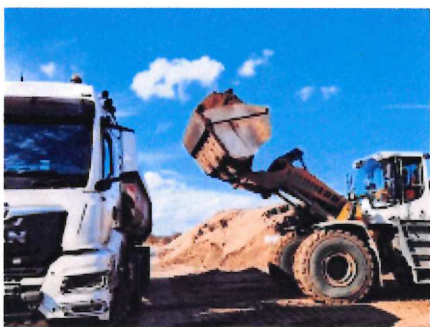
Für den Um- und teilweisen Neubau eines Umspannwerks lieferte die BVO 41.000 t Bodenmaterial
